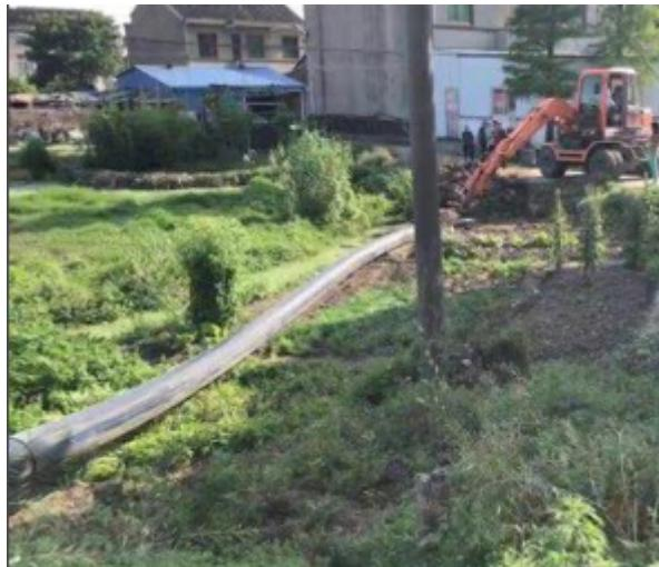
顶管施工特点：（1）先进顶管施工时不用封路施工，顶管施工选用的工作井与接受井又位于闲置之处，顶进过程中路上交通照常通行。（2）不需要开挖、回填和路面修复，所以与大开挖施工对比，能降低工程总造价。（3）泥水循环法施工避免了泥水横溢和稀泥乱堆放的不良现象，确保自然环境不受到污染，能做到文明施工。（4）先进顶管方法是全自动遥控，不需工人在管道内工作，这样消除了工人繁重的体力劳动，对工人安全也有了足够的保证。（5）先进顶管推进过程中挖进机及管道周围处于主动土压力与被动土压力之间，故对原土干扰极少，所以不会导致路面沉降以至产生裂纹，避免了路面重修。
