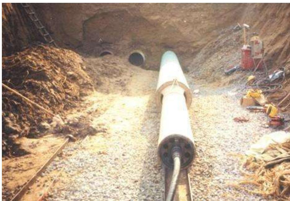
牵引管是一项不容易施工好的工程，也是一种不太为人知的工程。非开挖工程技术彻底解决了管道埋设施工中对城市建筑物的破坏和道路交通的堵塞等难题，在稳定土层和环境保护方面凸显其优势。这对交通繁忙、人口密集、地面建筑物众多、地下管线复杂的城市是非常重要的，它将为城市创造一个洁净、舒适和美好的环境。非开挖技术是近几年才开始频繁使用的一个术语，它涉及的是利用少开挖，即工作井与接收井要开挖，以及不开挖，即管道不开挖技术来进行地下管线的铺设或更换。通过工作井把要埋设的管子顶入土内，一个工作井内的管子可在地下穿行2000米以上，并且还能曲线穿行，以绕开一些地下管线或障碍物。宁波钢管道安装施工哪家好
